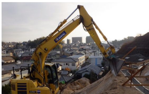
【掘削状況(ICT建機使用)】
