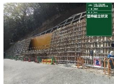
【型枠組立作業状況】
