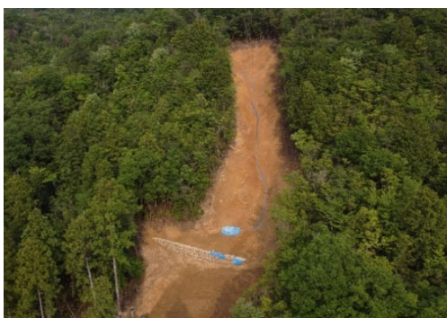
【施工状況(土留工)】
