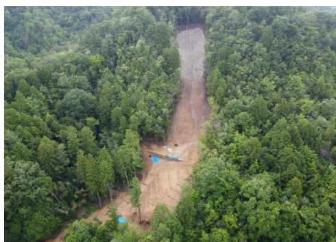
【施工状況（簡易法枠工・丸太筋工）】
