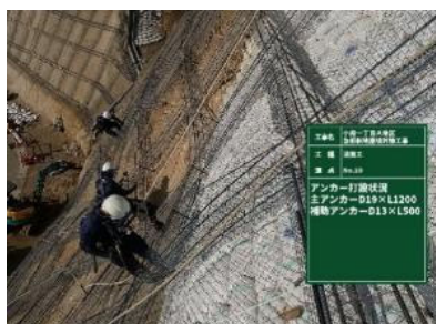
【法枠作業状況】
