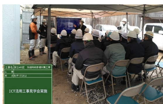
【ICT活用工事見学会実施】
