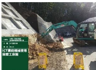
【掘削作業状況】
