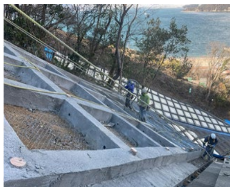
【マルチ吹付 作業状況】
