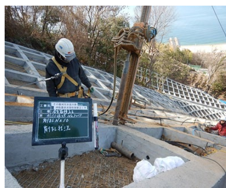
【鉄筋削孔 作業状況】
