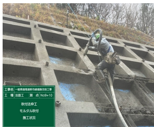
【モルタル吹付作業状況】
