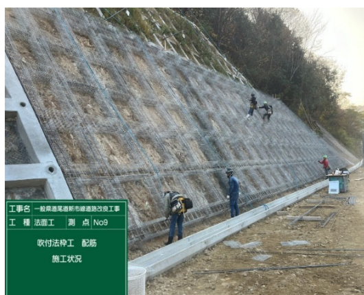
【法枠組立作業状況】
