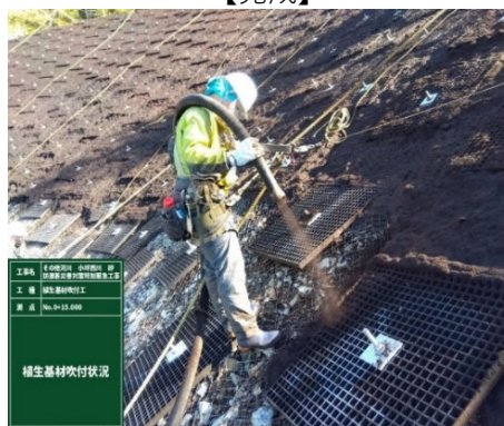
【植生基材吹付状況】
